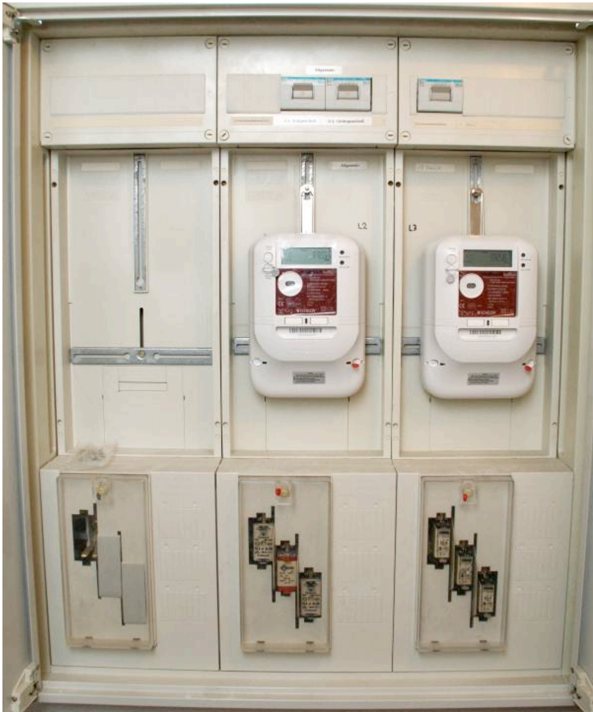
Abb. 2: Einbau der Stromzähler, (Quelle: Stadtwerk Haßfurt GmbH).
