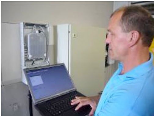
Abb. 4: Parametrierung eines Datenkonzentrators, (Quelle: Stadtwerk Haßfurt GmbH).
